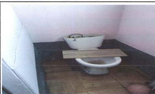
Foto 5: sustitucion de sanitario
