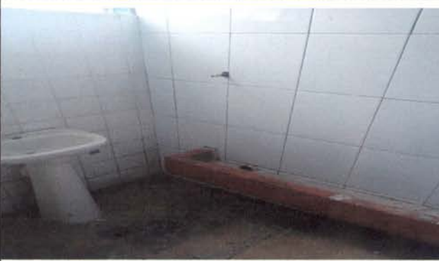
INSTALACION DE AZULEJO EN BAÑOS
