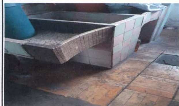
Foto 3: sustitucion de pila
