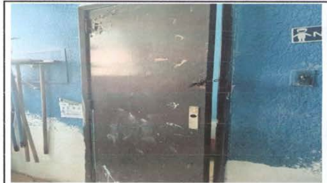
REMOZAMIENTO DE PUERTA
