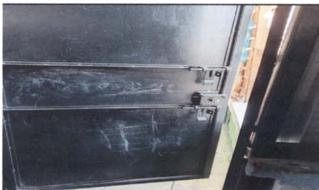
INSTALACION DE CHAPA EN BODEGA 2DO NIVEL
