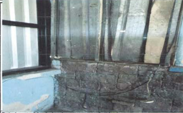
Foto1: cambio de lamina en segundo nivel
