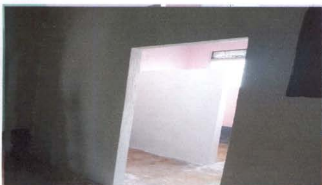
FABRICACION DE PREFABRICADO EN BAÑOS DE NIÑOS CON DUROCK
