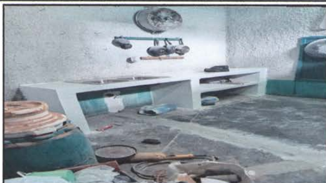
INSTALACION DE DRENAJE EN AREA DE COCINA
