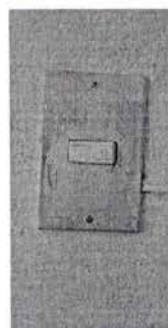
Foto 8: Sustitución interruptores simples
