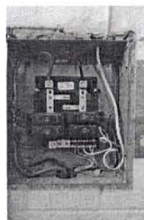
Foto 10: Reparación de cableado eléctrico
