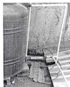
Foto 12: Sustitución de accesorios depósito de agua
