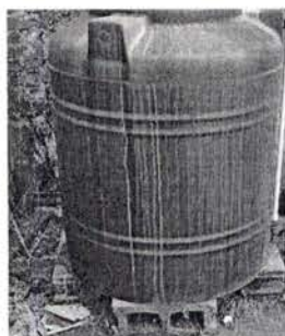
Foto 11: Sustitución de depósito de agua 1100 lt
