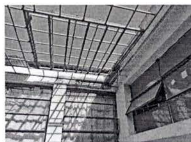
Foto 6: Mantenimiento a barandas de metal
