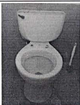
Foto 5: Sustitución de sanitarios
