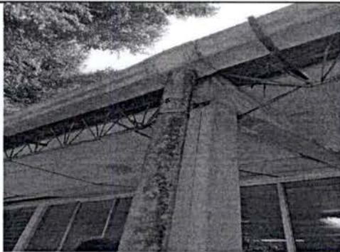
Foto 9: Sustitución de canal de pvc por lámina calibre 26
