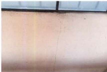
Foto 3: remozamiento de pared
