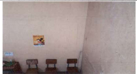
Foto 6: remozamiento de pared
