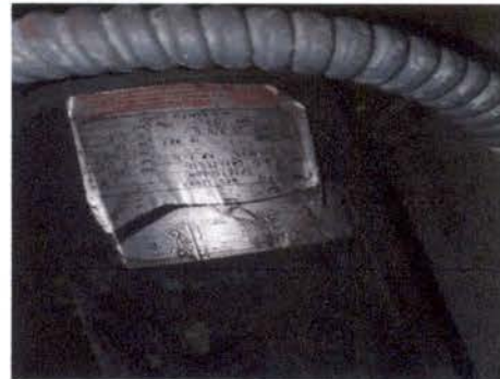
Foto 4: instalacion bomba de agua
