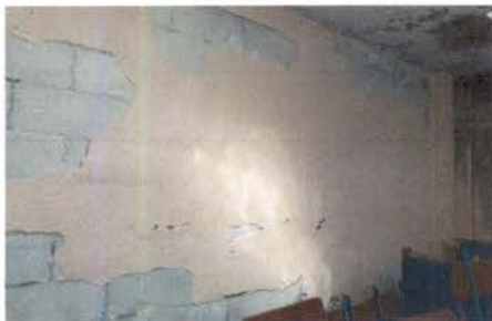
Foto 5: Remozamiento de pared
