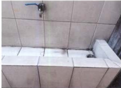
Foto1: cambiar loza lavamanos
