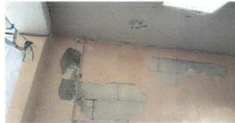
Foto 4: remozamiento de pared
