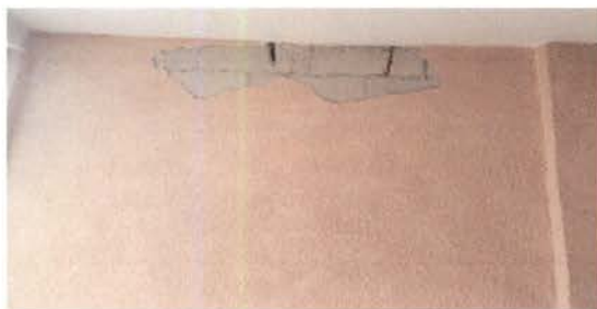
Foto 5: remozamiento de pared
