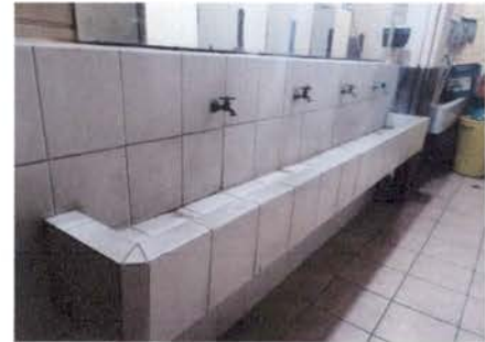
Foto 2: cambiar loza lavamanos
