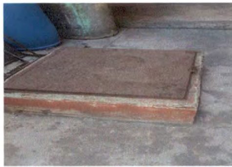
Foto 2: TAPADERA DE CISTERNA
