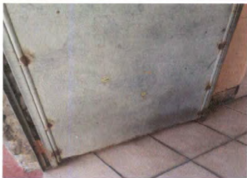
Foto 1: Cambio de puerta baño de maestros
