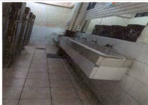
Foto 1: Cambio de azulejo y chorros , lavamanos
