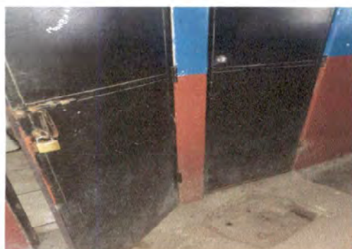
Foto 3: Cambio de puertas de baños primer nivel
