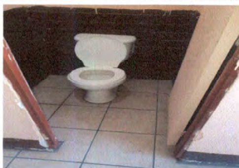
Foto 5: Cambio de puertas y sanitario, de maestros
