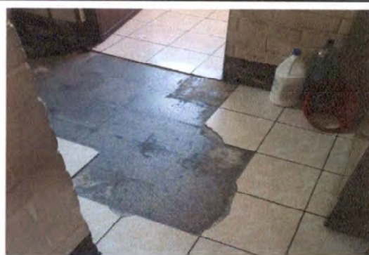
Foto 2: Reparación de Azulejo de Secretaria
