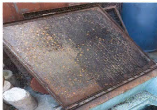
Foto 2: Remozamiento de Tapadera y pintura de cisterna
