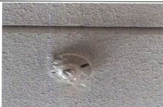
Foto 5: Reparación de flaponeras y colocar bombillas
