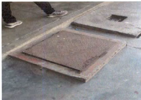
Foto 1: TAPADERA DE CISTERNA
