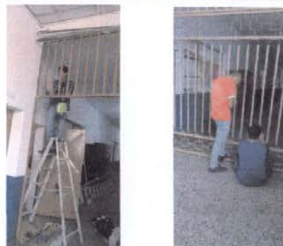
Foto 10: Baranda corredor central
