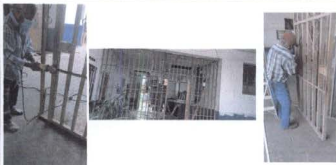
Foto 9: Baranda entrada principal
