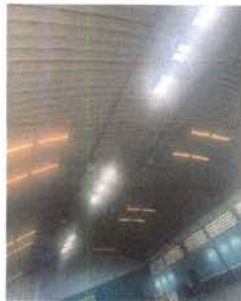
Foto 11: Sustitución de lamparas en el gimnasio
