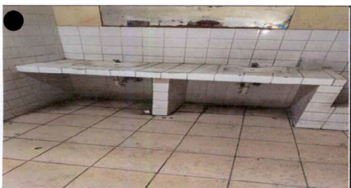
desinstalación e instalación de lavamanos
