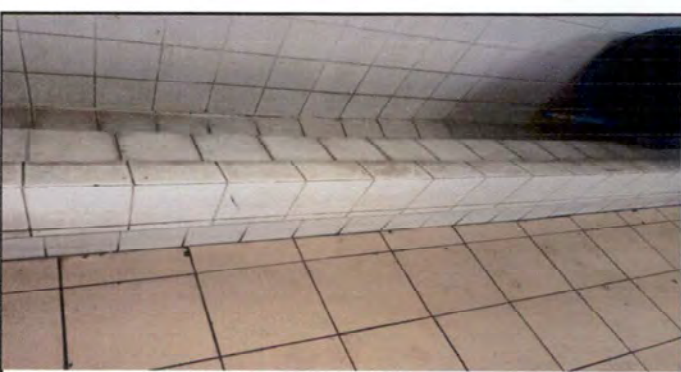
instalación de urinal (definir marca)
