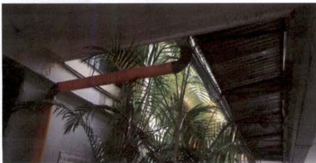
FOTO 5: Reparación de bajada de agua pluvial, tubo PVC 4 con accesorios
