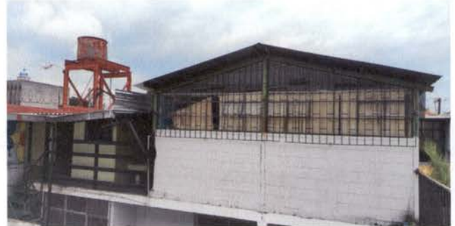
FOTO 2: Sustrucción de lámina, por lámina troquelada aluzinc calibre 26 para cubrir espacios entre techo y ventaneria
