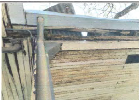
Foto 5: MÓDULO IV - Estado de machimbre en corredor patio juntas cívicas.
