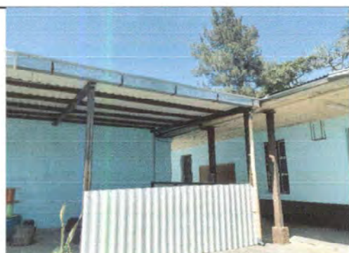
Foto 11: MÓDULO V - Espacio para cocina carese de estructura portante de metal
