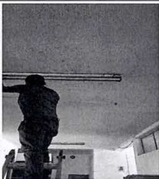
CAMBIO DE BOMBILLAS LED DE ALTA DENSIDAD
