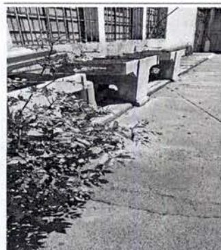
CAMBIO DE PILAS DE 2 LAVADEROS
