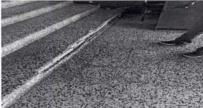
REPARACION DE GRADA DE INGRESO PRINCIPAL
