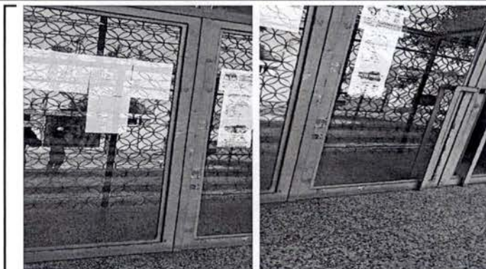
REMOSAMIENTO DE PORTON DE INGRESO ENTRADA PRINCIPAL
