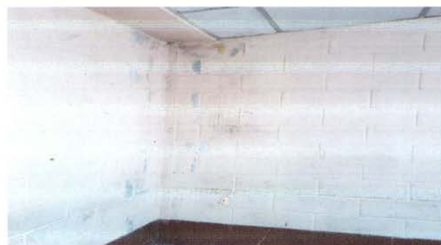
REVISIÓN, LIMPIEZA, DESTAPE DE BAJADAS DE AGUA Y FABRICACIÓN DE CAJAS DE REGISTRO
