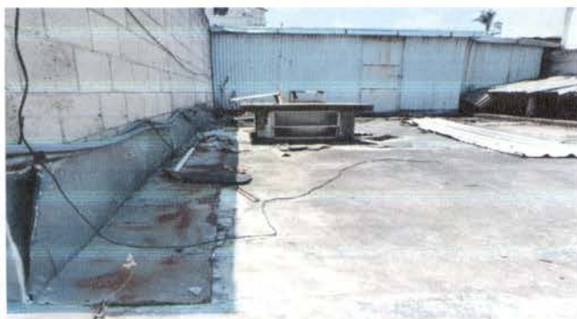
IMPERMEABILIZACIÓN DE LOZA
