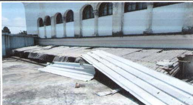
CAMBIO DE LAMINA A LAMINA TROQUELADA
