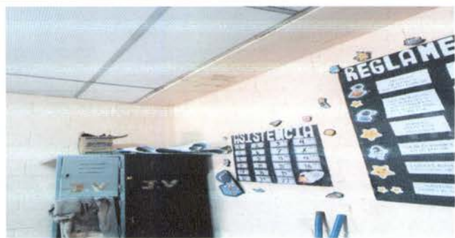
IMPERMEABILIZACION DE CANAL DE CONCRETO EN AULAS
