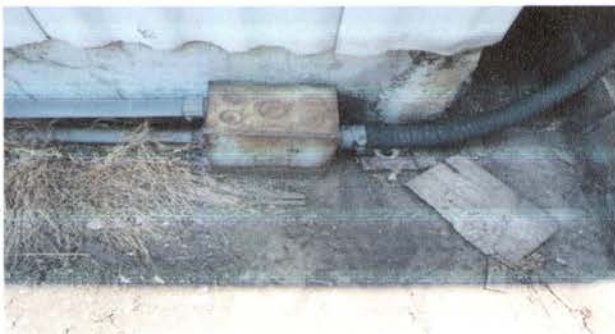
CAMBIO DE CAJAS DE REGISTRO
