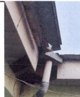
Foto 6: RENG LÓN 7 "CANALES Y BAJADAS DE AGUA"
