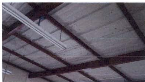
Foto 6: RENGLÓN 17 "DESINSTALACIÓN DE LÁMAPARA POR PLAFONERA"
