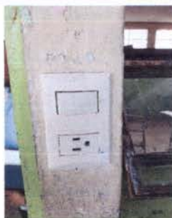
Foto 5: RENGLÓN 17 "REPARACIÓN DE SISTEMA ELÉCTRICO"
