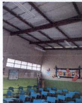
Foto 2: RENGLÓN 9 "PINTURA EN MUROS INTERIORES Y EXTERIORES"
