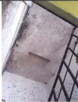
Foto 1: RENG LÓN 3 "IMPERMEABILIZACIÓN DE LOZA"
