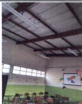
Foto 3: RENGLÓN 9 "PINTURA EN MUROS INTERIORES Y EXTERIORES"
