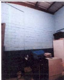
Foto1: RENGLO 20 "INSTALACIÓN DE AZULEJO, PLANCHA FUNDIDA DE CONCRETO Y ENTREPAÑO"
