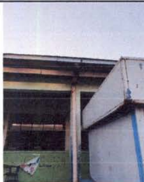
Foto1: RENGLÓN 7 "CANALES Y BAJADAS DE AGUA PLUVIAL"
