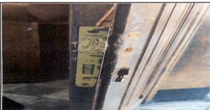
Foto 3: Cambio de chapas
