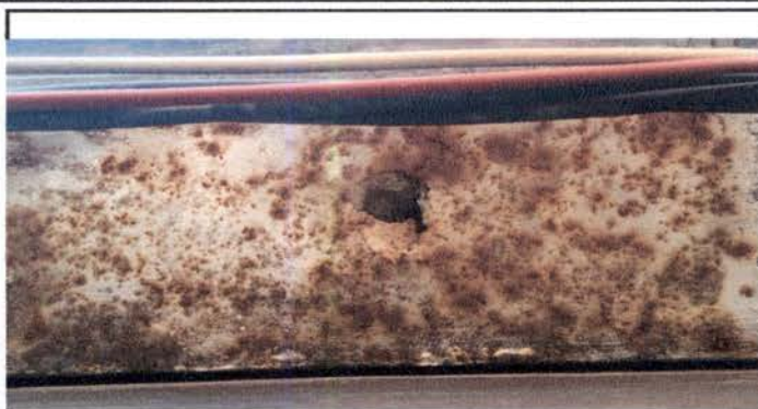
Foto1: Cambio de Canal
