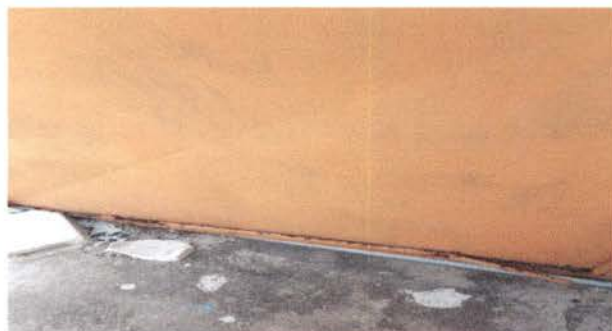
Foto 4: Mantenimiento en puertas
