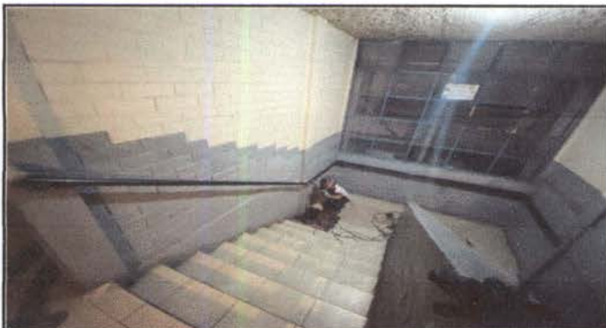
Foto 9: COLOCACIÓN DE PASAMANOS
