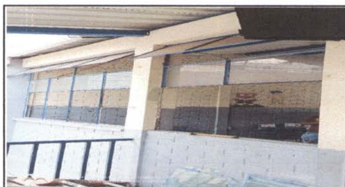
Foto 6: SUSTITUCIÓN DE ESTRUCTURA DE METAL Y VENTANA
