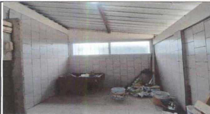
Foto7: CAMBIO AZULEJO DE COCINA
