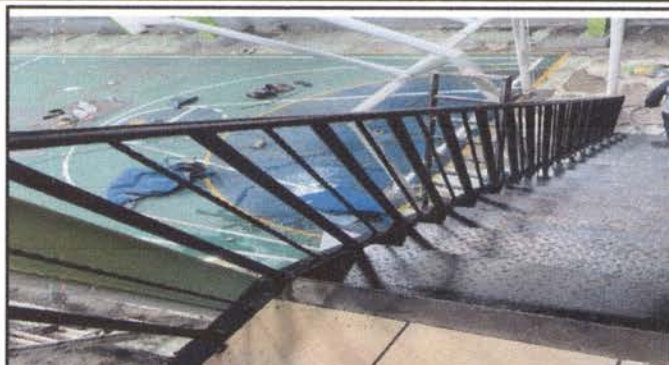
Foto 8: CAMBIO DE LAMINA DE GRADAS
