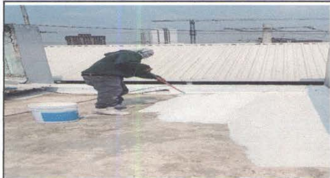
Foto1: IMPERMEABILIZACIÓN DE LOZA CORREDOR
