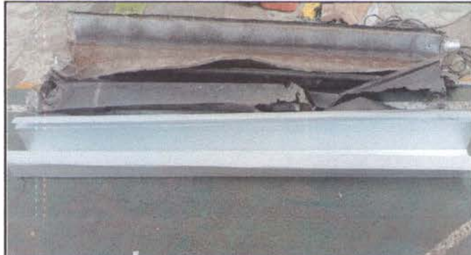
Foto 2: SUSTITUCIÓN DE CANAL DE METAL
