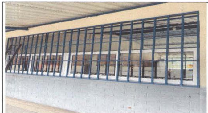
Foto 4: COLOCACIÓN DE BALCONES
