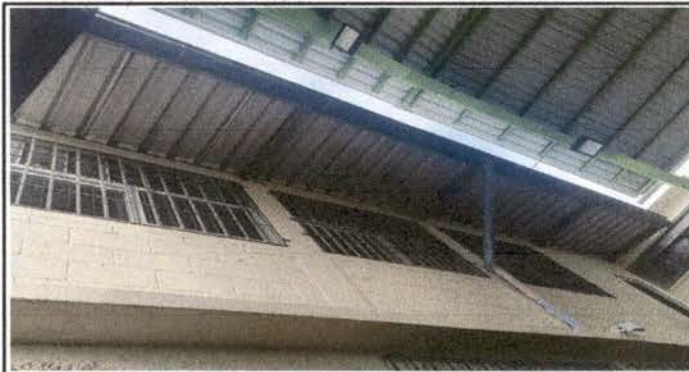
Foto 2: SUSTITUCIÓN DE CANAL DE METAL
