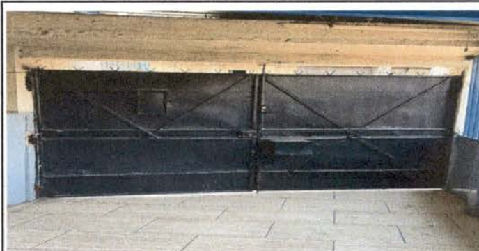
Foto 16: SUSTITUCION DE PUERTA DE METAL
