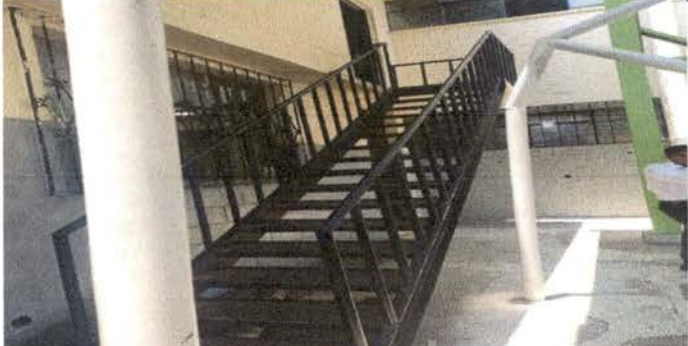
Foto 6: MANTENIMIENTO DE GRADAS DE METAL TIPO LABRADA
