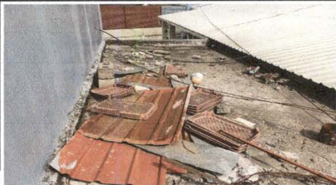
Foto 1: IMPERMEABILIZACIÓN DE LOZA CORREDOR
