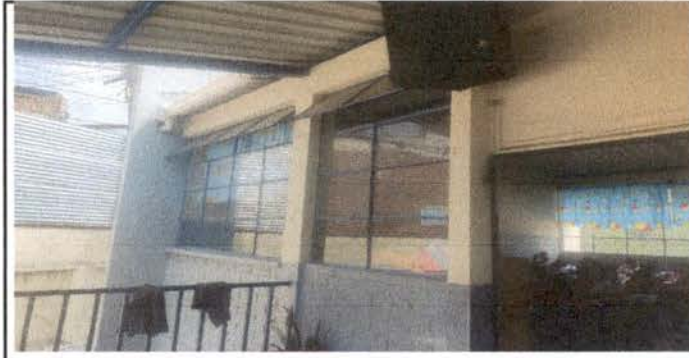
Foto 6: SUSTITUCIÓN DE ESTRUCTURA DE METAL Y VENTANA
