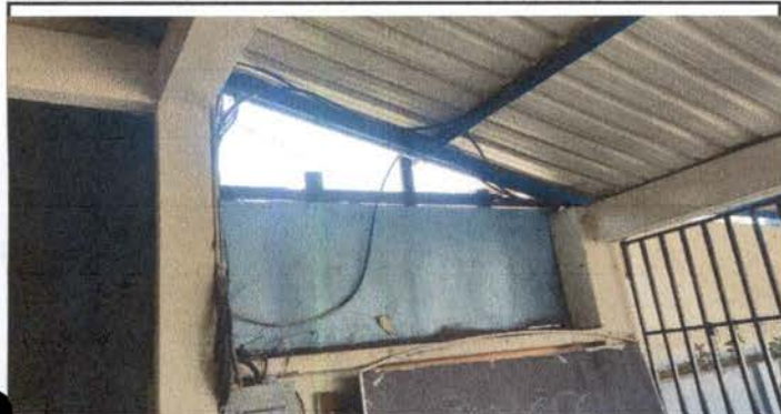
Foto 7: SUSTITUCIÓN DE ESTRUCTURA DE METAL VENTANA CORREDOR
