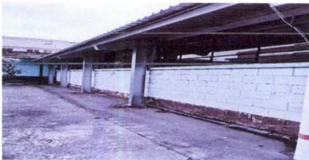
Foto 3: Estructura metálica del techo.
