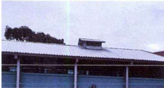
Foto 1: Cambio de techo
