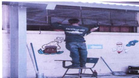
Foto 4: estructura metálica de ventanas
