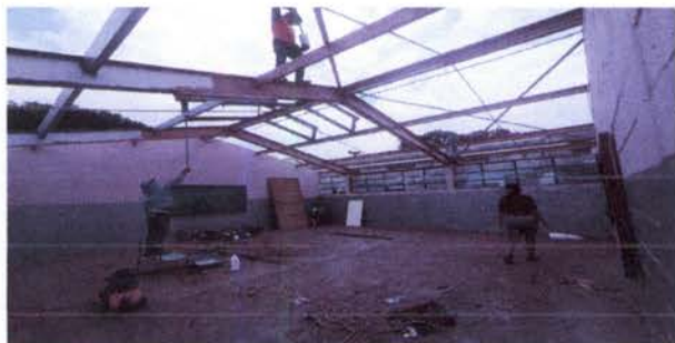
Foto1: Cambio de techo
