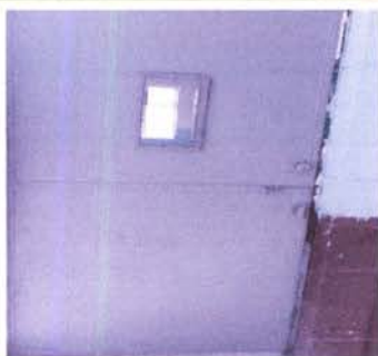
Foto 5: Puerta de metal, ventilación
