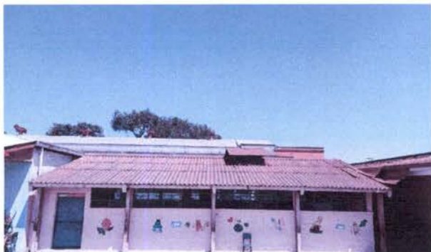
FOTO 1: TECHO DE AULA
