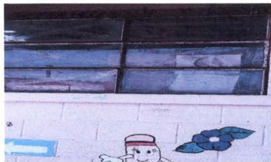
FOTO 6: ESTRUCTURA DE VENTANA
