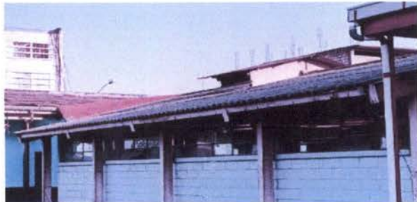
FOTO 1: TECHO DE AULA
