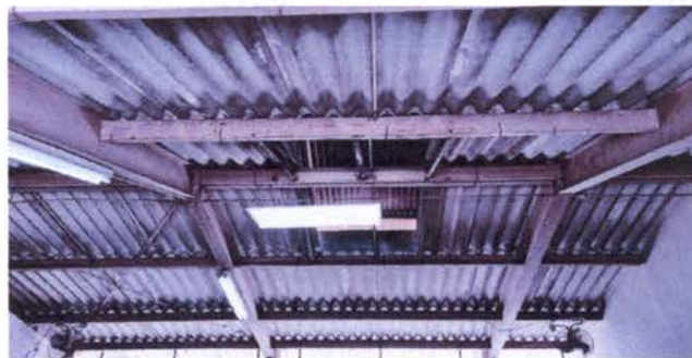
FOTO 2: ESTRUCTURA DEL TECHO
