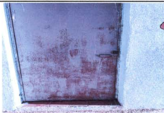
FOTO 4: PUERTA DE METAL
