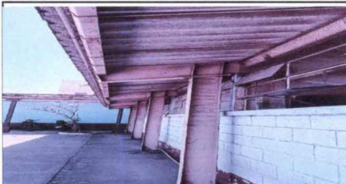
FOTO 3: ESTRUCTURA DEL TECHO
