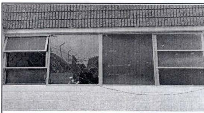
Desinstalación e instalación de vidriera de metal corrediza dirección JV
