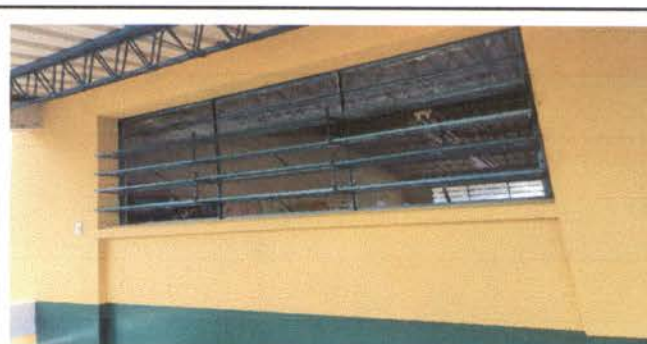
Foto 6 Mantenimiento a estructura de metal de ventana
