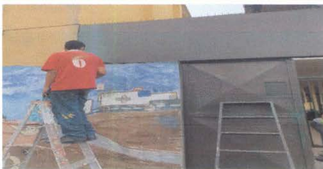
Foto 11 Mantenimiento de portones de metal
