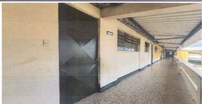
Foto 7 Pintura a muros exteriores
