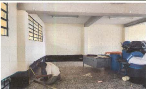
Foto 9 Pintura de muros interiores
