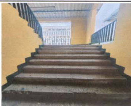
Foto 8 Pintura a muros exteriores
