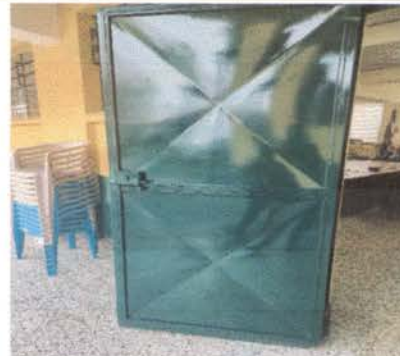
Foto 2 Mantenimiento a estructura de puerta de metal
