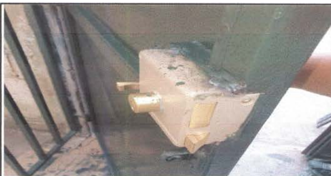
Foto 3 Sustitución de chapa de portón
