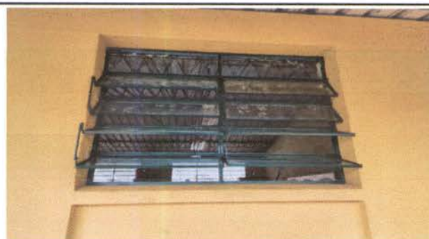
Foto 5 Mantenimiento a estructura de metal de ventana
