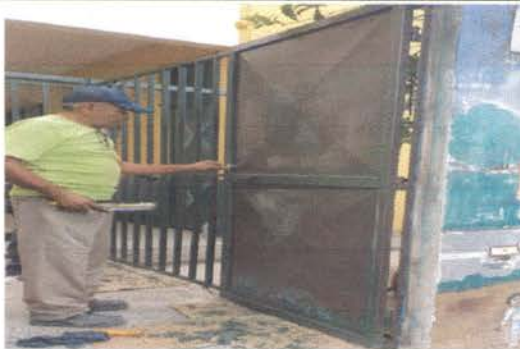
Foto 12 Mantenimiento de portones de metal
