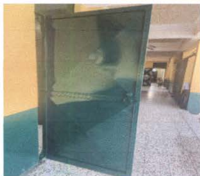
Foto 1 Mantenimiento a estructura de puerta de metal
