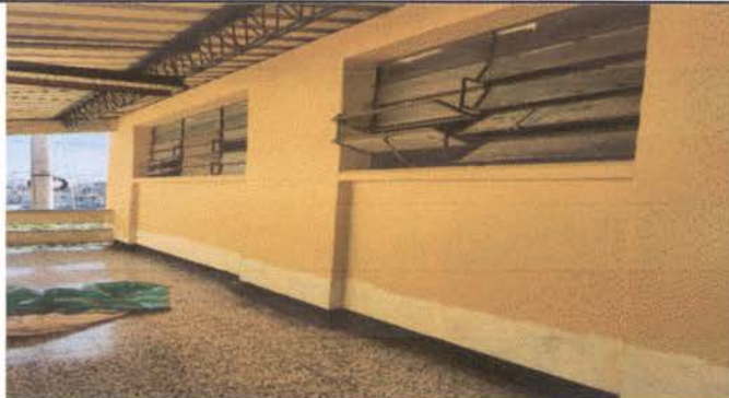
Foto 10 Pintura de muros exteriores e interiores
