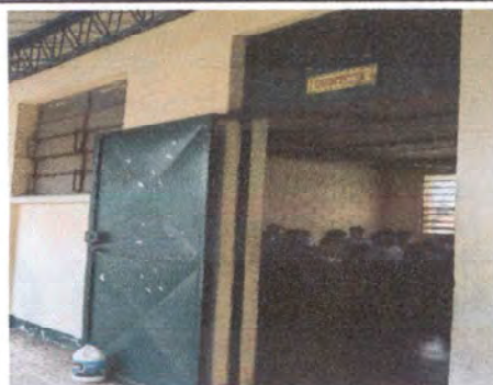
Foto 2 Mantenimiento a estructura de puerta de metal
