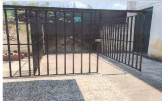
Foto 14 Mantenimiento a rejas
