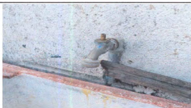
Foto 15 Sustitución de llave de chorro
