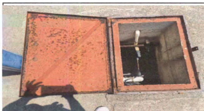
Foto 17 Limpieza e impermeabilización de Cisterna
