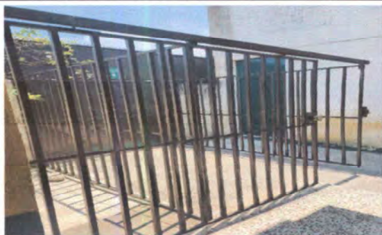
Foto 13 Mantenimiento a rejas
