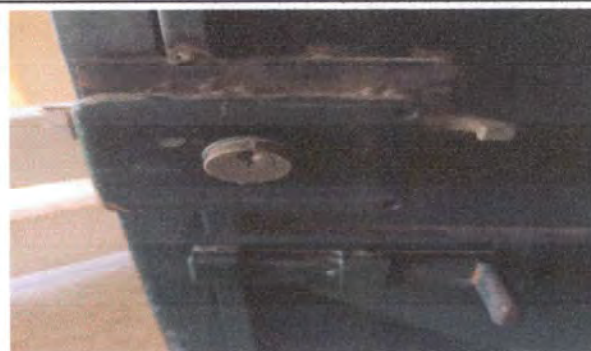
Foto 4 Sustitución de chapa a puerta de clase
