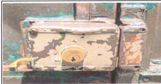
Foto 3 Sustitución de chapa portón
