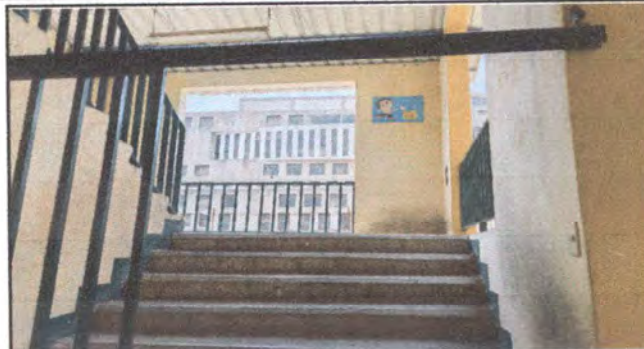
Foto 8 Pintura en muros exteriores
