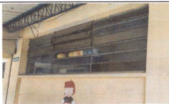
Foto 6 Mantenimiento a estructura de metal de ventana
