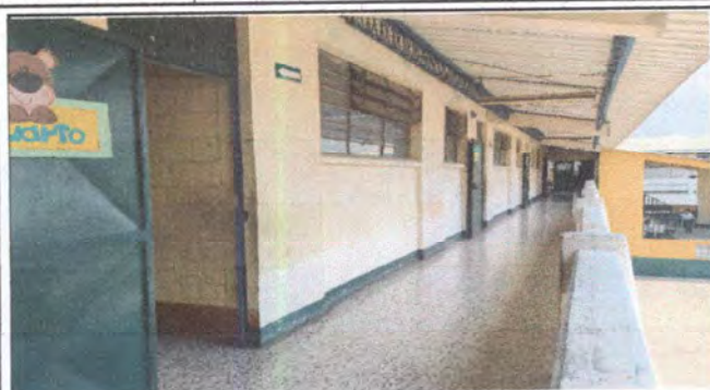
Foto 7 Pintura en muros exteriores
