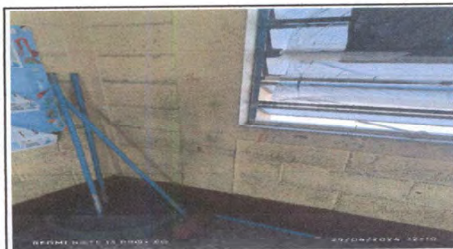
Foto 9 Pintura de muros interiores
