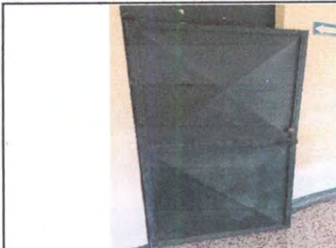
Foto 1 Mantenimiento a estructura de puerta de metal
