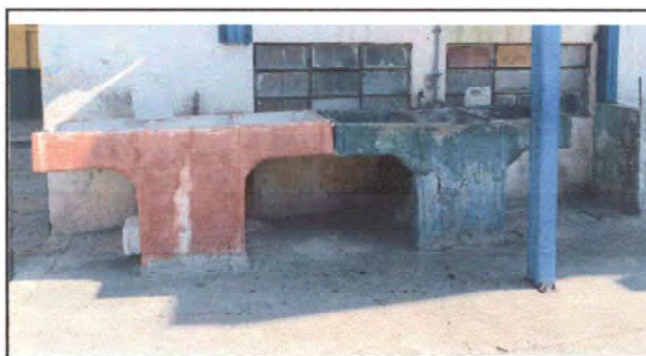
Foto 18 Sustitución de pila de cemento de dos lavaderos.
