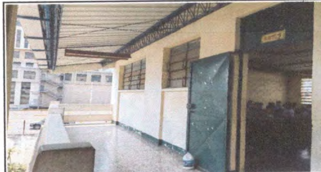
Foto 10 Pintura de muros exteriores e interiores
