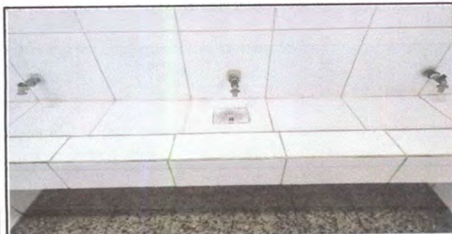
Foto 11 Sustitución de grifos
