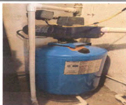
Foto 16 Sustitución de bomba de agua star-rite y sistema accesorio, hidroneumático.
