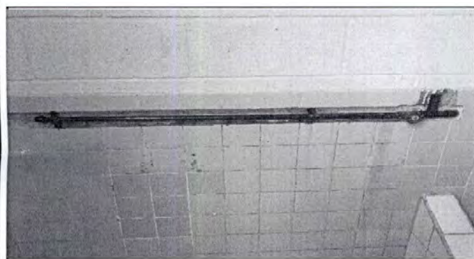
Reparación de Urinal (cambio de llave y tubería) en sanitarios JM
