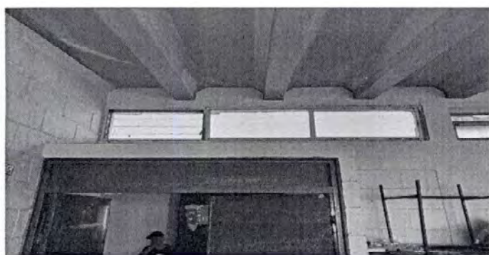
Mantenimiento de estructuras en aulas.
