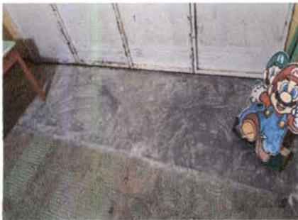
Foto 5: Reparación de piso de torta de concreto
