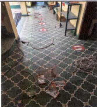
Foto 9: REPARACION DE SISTEMA ELECTRICO
