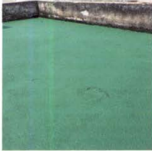
Foto 3: Impermeabilización de losa
