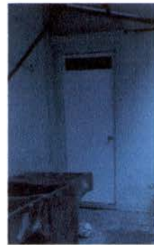
Foto 4: Sustitución de puerta de en servicio sanitario
