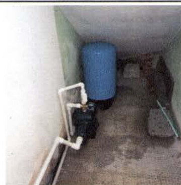
Foto 10:REPARACION Y MANTENIMIENTO DE CISTERNAS/DEPOSITOS DE AGUA
