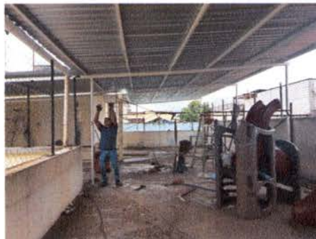
Foto 8: Reparacion de tubo hg y malla galvanizada
