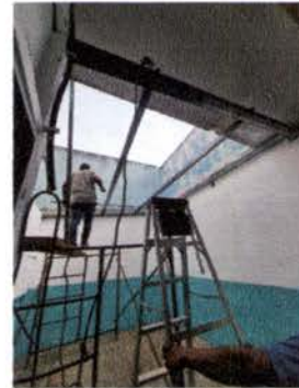
Foto 2: ESTRUCTURA DE TECHO
