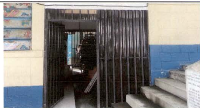
Foto 6: Sustrucción de láminas de policarbonato por láminas greca policarbonato bronce en área de puertas de bodega de implementos de educación física.
