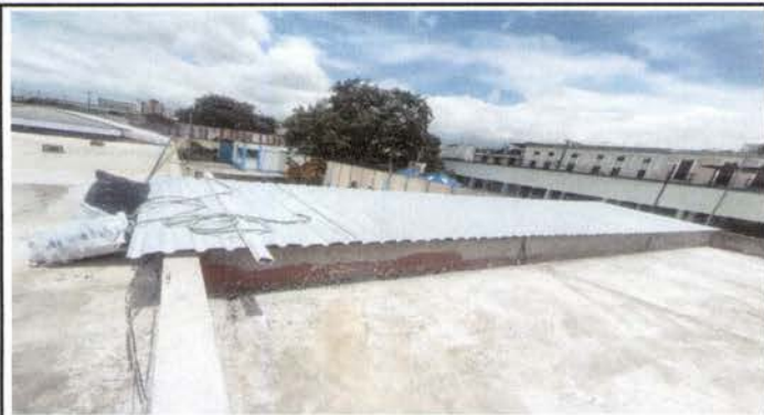
Foto 1: Sustrucción de láminas de zinc en el área de techado de entrada a sanitarios y cocina, por láminas de aluzinc calibre 26.
