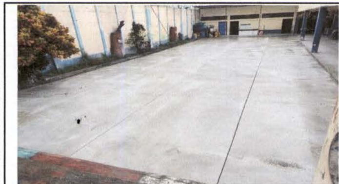
Foto1: Reparación de planchas de concreto en patio central (Losa de patio)
