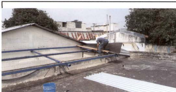
Foto 4: Sustitución de láminas de policarbonato por láminas de aluzinc calibre 26 en el área de techado de bodega de implementos de educación física.
