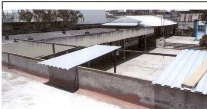
Foto 3: Sustitución de láminas de zinc en el área de techado de entrada a sanitarios y cocina, por lámina de aluzinc calibre 26.
