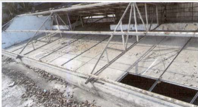
Foto 1: Sustrucción de láminas de policarbonato por láminas de aluzinc calibre 26 en área de techado de sala de maestras.
