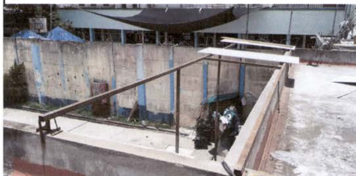
Foto 2: Sustitución de láminas de aluzinc en el área de entrada a sanitarios y cocina, por láminas de aluzinc calibre 26.
