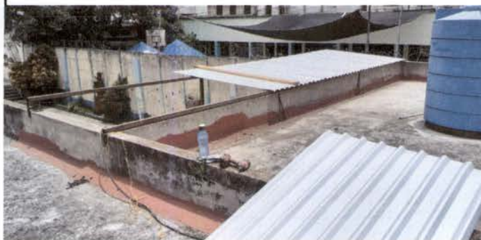
Foto 1: Sustitución de láminas de zinc en el área de techado de entrada a sanitarios y cocina, por láminas de aluzinc calibre 26.
