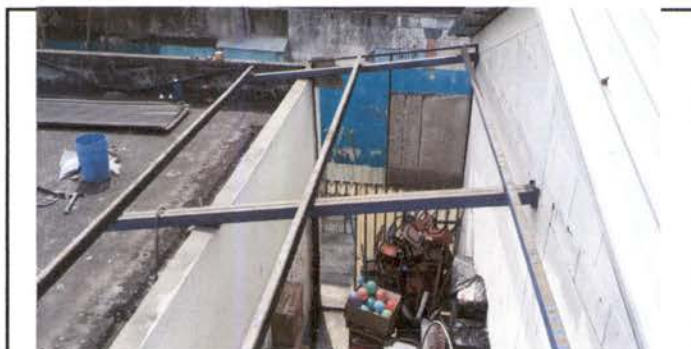
Foto 5: Sustitución de láminas de policarbonato por láminas de aluzinc calibre 26 en el área de techado de bodega de implementos de educación física.
