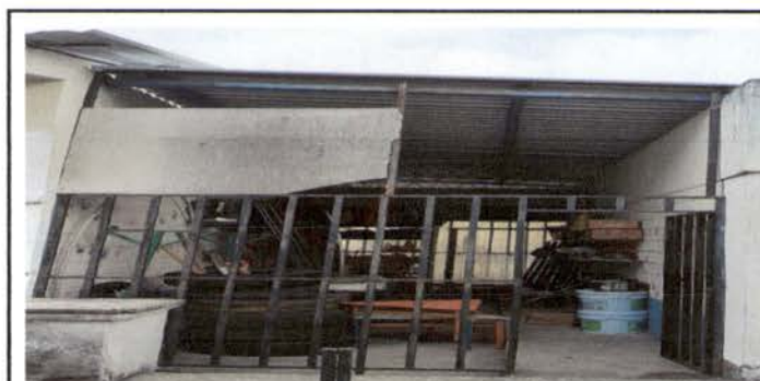
Foto 6: Sustitución de láminas de policarbonato por láminas de aluzinc calibre 26 en el área de techado de bodega de implementos de educación física.
