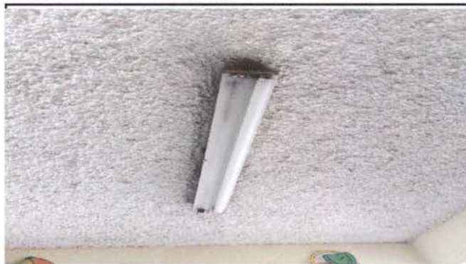
FOTO ÍTEM 5: Sustrucción de tubo de halógeno 40 wats en lámparas de dos tubos por tubos tipo led en 7 aulas y corredor. Eliminando balastos.
