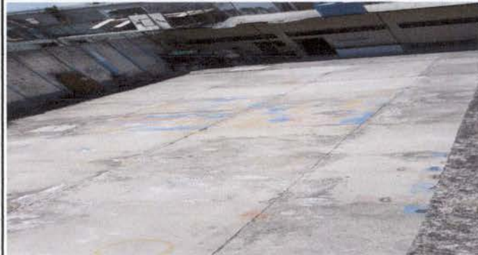
FOTO ÁREA 2: Reparación de losa de patio 1 que se encuentra levantada por raíces de árboles.
