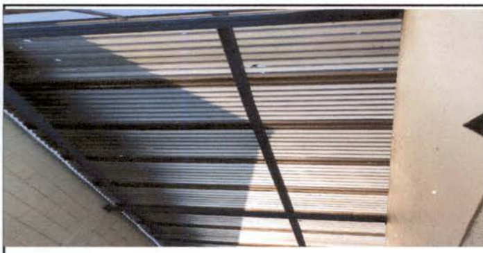
Foto ÍTEM 1.2: Sustitución de láminas de plástico en el área de techado de bodega de implementos de física que se encuentran perforadas y en mal estado. Por lámina de aluzinc calibre 26
