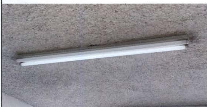
FOTO ÍTEM 5: Sustrucción de tubo de halógeno 40 wats en lámparas de dos tubos por tubos tipo led en 7 aulas y corredor. Eliminando balastos.
