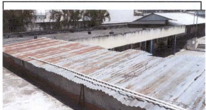
Foto1.1: Sustitución de zinc en el área de techado de sanitarios que se encuentran dobladas y en mal estado por el peso de las ramas de los árboles. Por láminas de aluzinc calibre 26.
