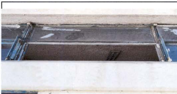
FOTO ÍTEM 6: Sustitución de vidrios en mal estado y quebrados en aulas, sanitarios de alumnos y cocina,
