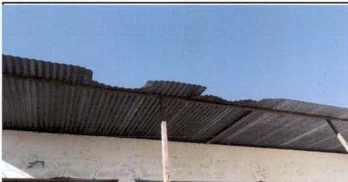
Foto ÍTEM 1.1: Sustitución de láminas de zinc en el área de techado de sanitarios que se encuentran dobladas y en mal estado por el peso de las ramas de los árboles por láminas de aluzinc calibre 26.
