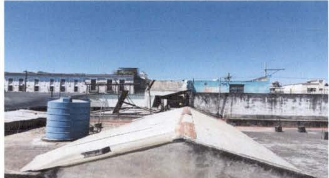
Foto ÍTEM 1: Sustitución de láminas plásticas en la sala de maestras que se encuentran en mal estado por láminas de aluzinc calibre 26.
