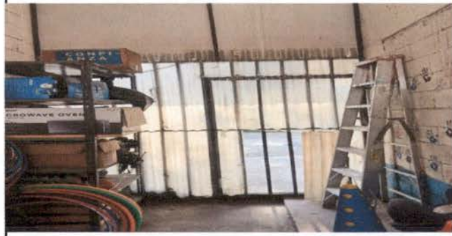
FOTO ÍTEM 8: Mejoramiento bodega de física, sustituyendo tabla yeso en las puertas laterales.
