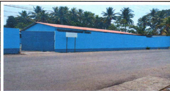
Foto 6: 9.1. Pintura en muros exteriores e interiores.
