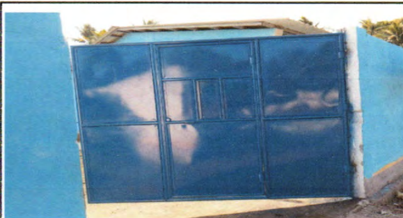
Foto 4: 4.5 Sustitución de portón de metal
