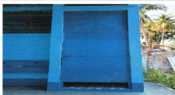
Foto 2: 4.3 Sustitución de puertas de metal
