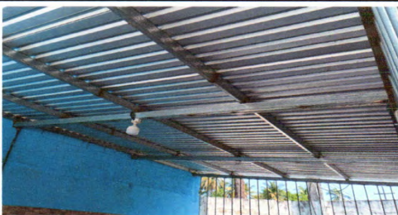
Foto 10: 17.3. Sustitución de lámparas tipo LED. 17.6. Sustitución de interruptores simples. 17.8. Sustitución de tomacorrientes dobles. 17.12. Sustitución de ducto eléctrico+accesorios.
