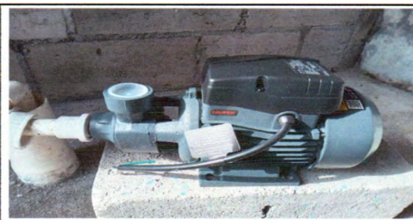
Foto 11: 18.7. Sustitución de bomba de agua.
