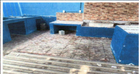
Foto 9: 13.1. Sustitución de azulejos
