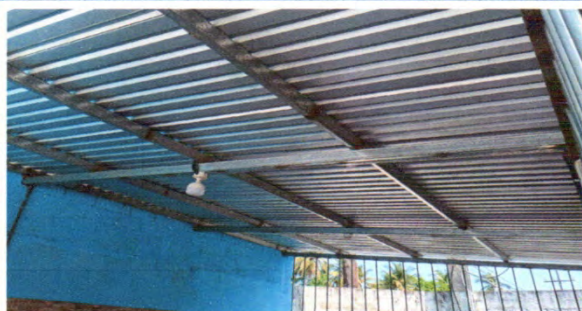
Foto 1: 1.1. Sustitución de lámina, por lamina troquelada aluzinc 26. 1.3. Sustitución de elementos de fijación. 2.3 Sustitución de estructura de soporte de metal por metal
