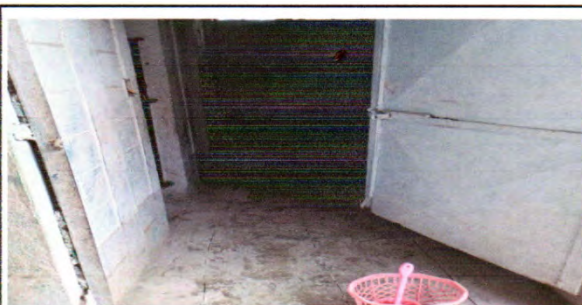
Foto 5: 6.8. Sustitución de piso cerámico.
