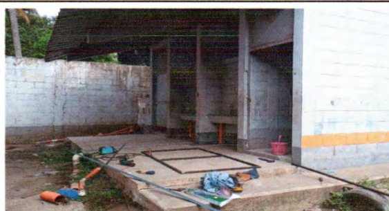
Foto 2: 4.3. Sustitución de puertas de metal.
