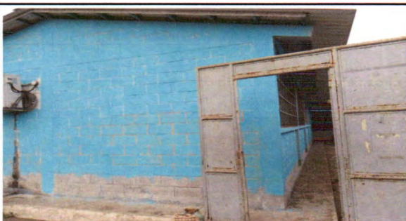
Foto 4: 4.5. Sustitución de portón de metal.
