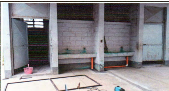
Foto 3: 4.4. Sustitución de puertas en servicios sanitarios
