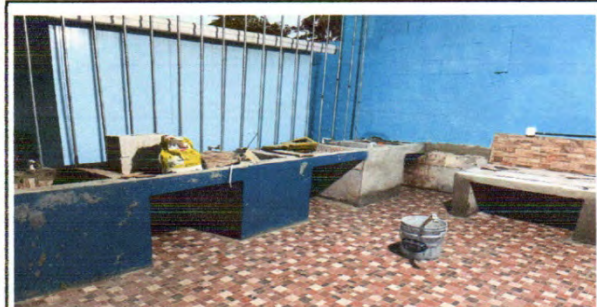
Foto 9: 13.1. Sustitución de azulejos
