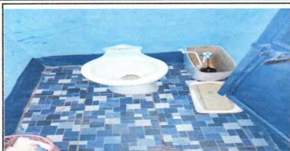
Foto 7: 10.3. Sustitución de inodoro
