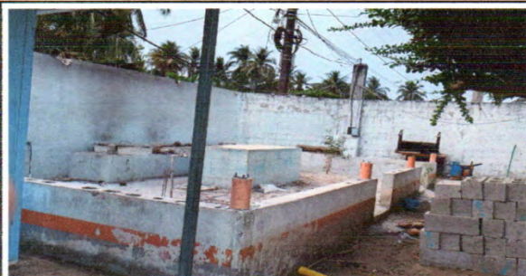
Foto 1: 1.1. Sustitución de lámina, por lámina troquelada calibre 26. 1.3. Sustitución de elementos de fijación. 2.3. Sustitución de estructura de soporte de metal, por metal.
