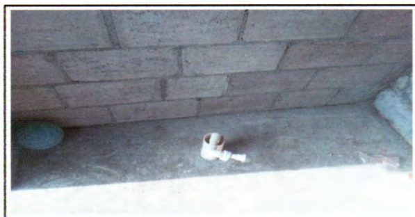
Foto 11: 18.7. Sustitución de bomba de agua.
