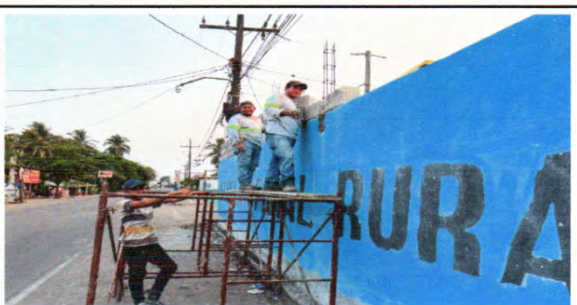
Foto 6: 9.1. Pintura en muros exteriores e interiores
