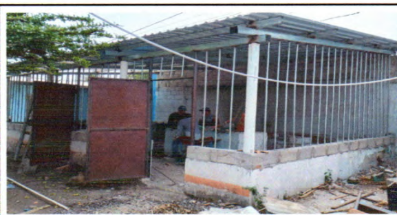
Foto 12: 20.8. Reparación de azulejos en muebles de cocina. 20.11. Sustitución de pila de cemento de un lavadero. 21.1. Repello en muro.
