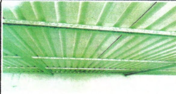
Foto 1: 1.1. Sustitución de lámina, por lámina troquelada calibre 26. 1.3. Sustitución de elementos de fijación. 2.3. Sustitución de estructura de soporte de metal, por metal.
