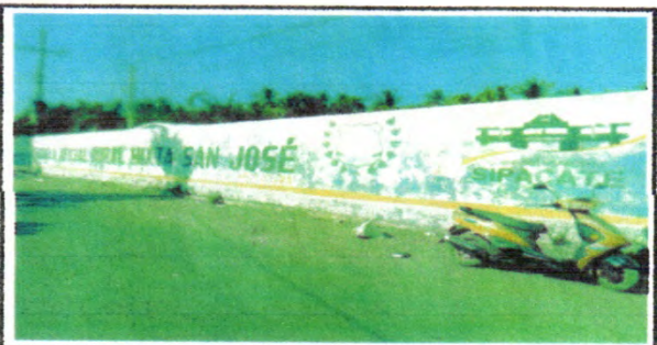
Foto 6: 9.1. Pintura en muros exteriores e interiores
