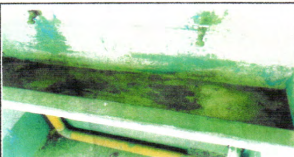
Foto 9: 13.1. Sustitución de azulejos
