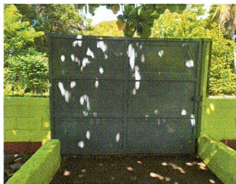
Foto 4: 4.5 Sustrucción de portón de metal.
