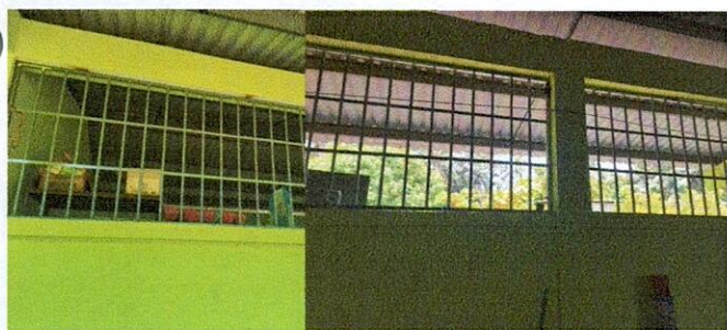
Foto 5: 5.2 Sustrucción de estructura de metal de ventana.
