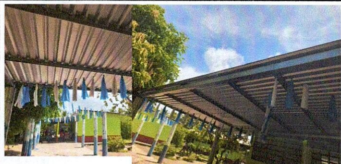
Foto 1: 2.1 Sustrucción de estructura de madera por metal.
