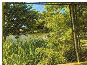
Foto 8: 15.2 Reparación de muro perimetral con tubo hg y malla galvanizada
