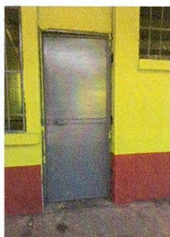
Foto 3: 4.1 Mantenimiento a estructura lijado, cepillado, sujeciones y aplicación de pintura.
