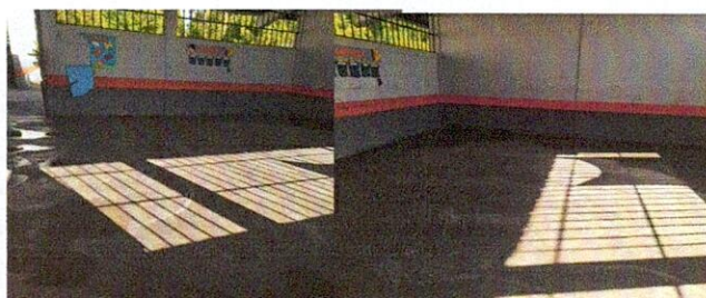
Foto 6: 6.2 Reparación de piso de cemento a liquido.
