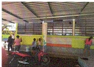
Foto 7: 9.1 Pintura en muros, interiores y exteriores.
