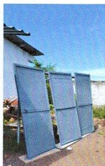
Foto 3: 4.1 Mantenimiento a estructura lijado, cepillado, sujeciones y aplicación de pintura.
