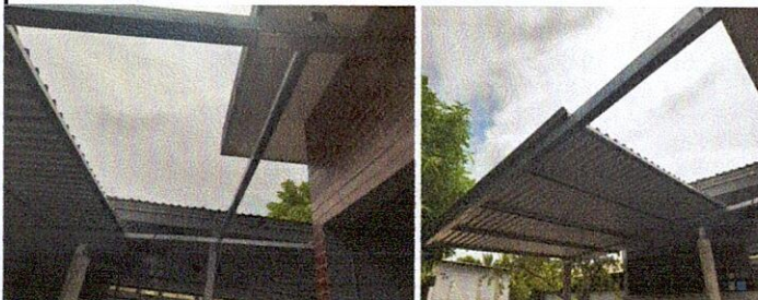
Foto 1: 2.1 Sustitución de estructura de madera por metal.
