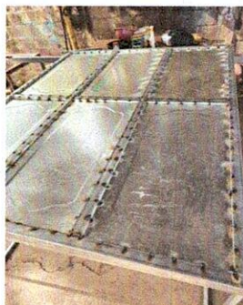
Foto 4: 4.5 Sustitución de portón de metal.
