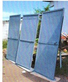
Foto 2: 4.1 Mantenimiento a estructura lijado, cepillado, sujeciones y aplicación de pintura.
