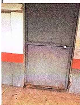
Foto 2: 4.1. Mantenimiento a estructura lijado, cepillado, sujeciones y aplicaci3n de pintura
