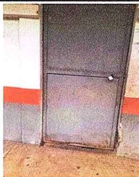
Foto 3: 4.1. Mantenimiento a estructura lijado, cepillado, sujeciones y aplicaci3n de pintura
