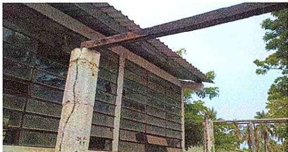
Foto 1: 2.1 Sustrucción de estructura de madera por metal
