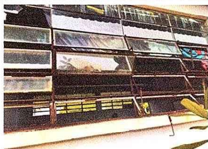
Foto 5: 5.2 Sustrucci3n de estructura de metal de ventana.
