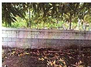
Foto 7: 9.1 Pintura en muros, interiores y exteriores.
