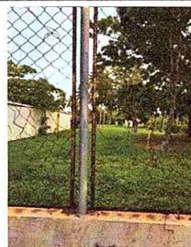
Foto 8: 15.2 Reparación de muro perimetral con tubo hg y malla galvanizada
