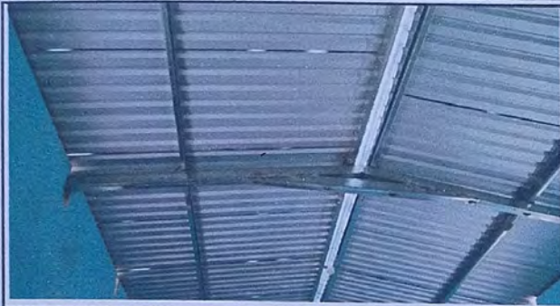
Foto 1: Costaneras instaladas
