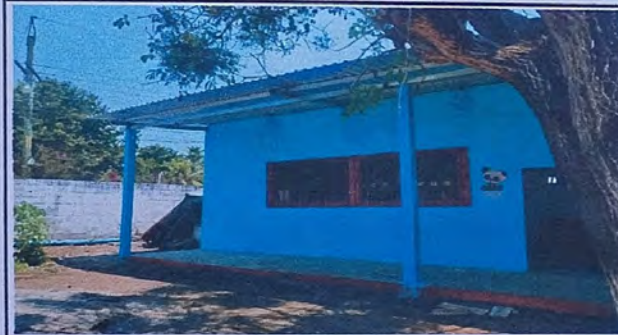
Foto 3: Columnas terminadas en el corredor
