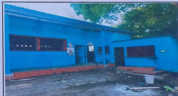
Foto 4: Lámina instalada en el corredor
