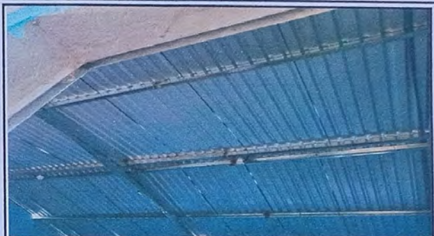
Foto 2: Lámina instalada dentro de las aulas
