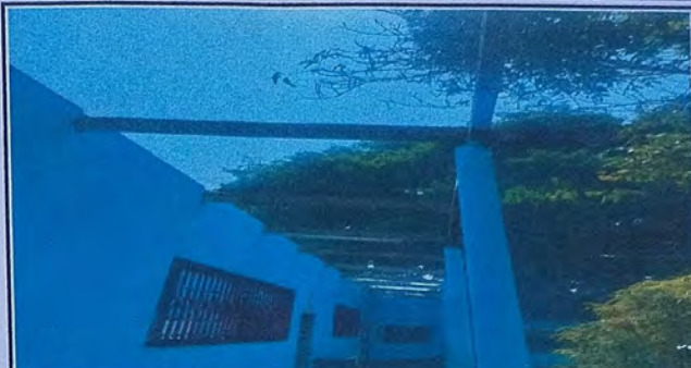
Foto 2: Desinstalación de láminas en el corredor
