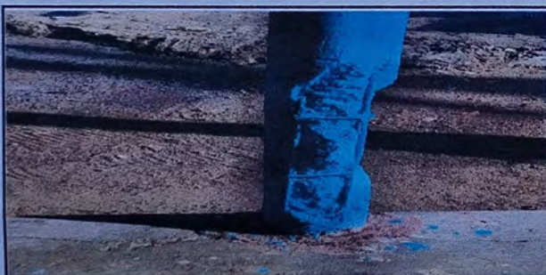
Foto 5: Columnas deterioradas
