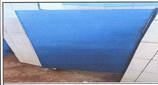
Foto 5: Sustitución de puestas sanitarias
