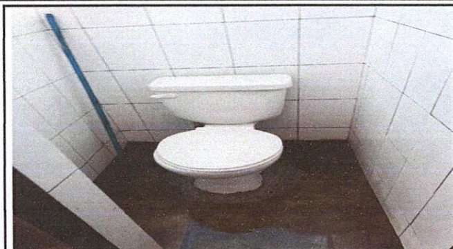
Foto: Sustitucion de inodoros
