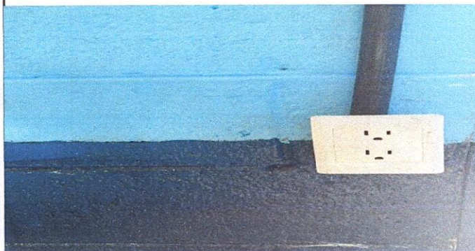
Foto 3: Sustitucion de tomacorrientes
