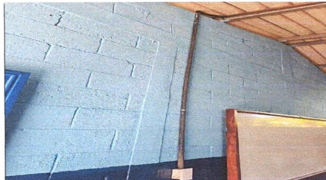
Foto 4: reparacion de cableado electrico
