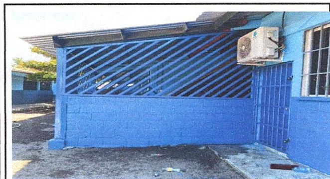
Foto 3: Sustitución de metal por metal
