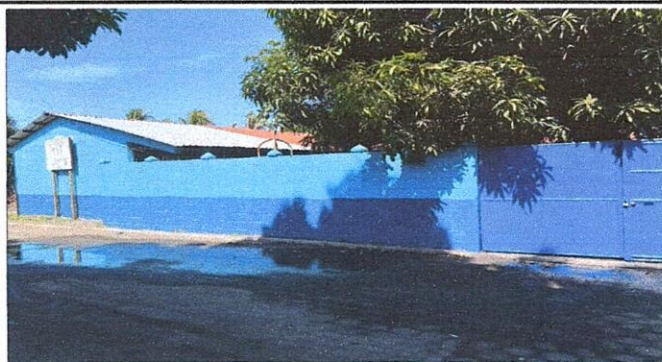
Foto 1: Sustitución de lamina troquelada
