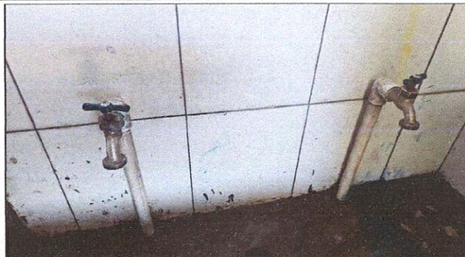
Foto 2: Sustitucion de llaves de chorros
