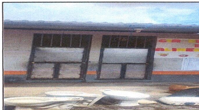
Foto 4: Sustitución de puertas
