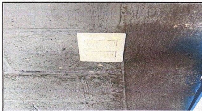
Foto 4: Sustitución de interruptores
