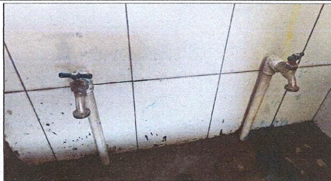
Foto 2: Sustitucion de llaves de chorros
