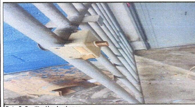
Foto 5: Sustitución de chapas
