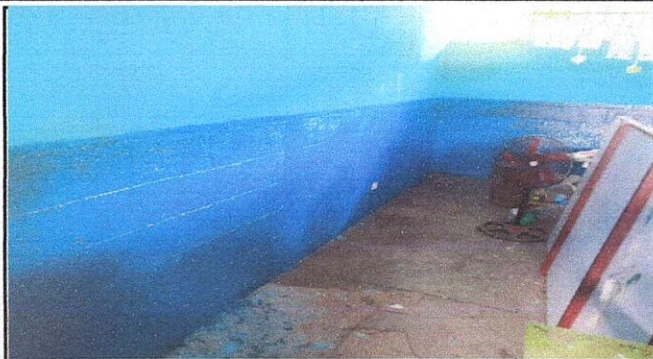
Foto: Pintura en muros interiores y exteriores
