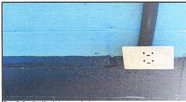
Foto 5: Sustitución de tomacorrientes
