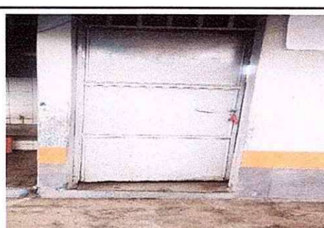
Foto 6: 4.3 Sustrución de puerta
