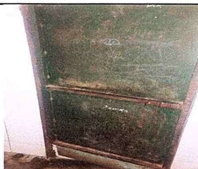
Foto 4: 4.1 Mantenimiento de estructura (lijado, cambio de tubo, cepillado, sujeciones y aplicación de pintura)
