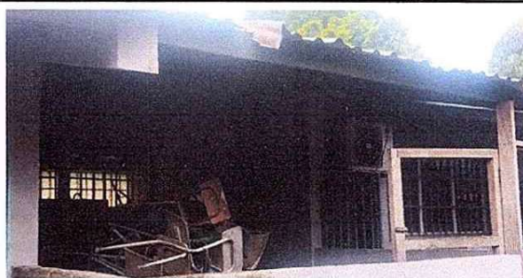
Foto 2: 5.6 Sustitución de balcanes de metal
