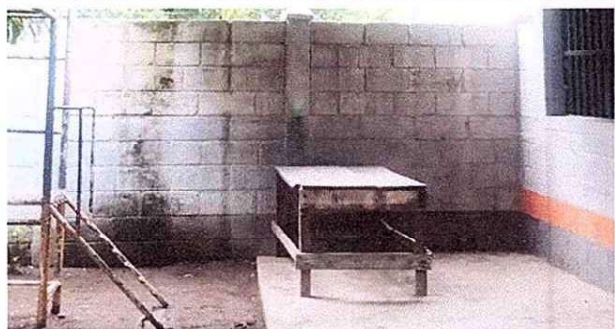
Foto 3: 9.1 Pintura de muros exteriores e interiores
