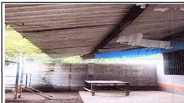
Foto 3: 2.3 Sustrución de estructura de soporte de metal, por metal
