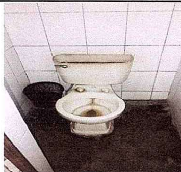
Foto 4: 10.3 Sustitución de inodoros
