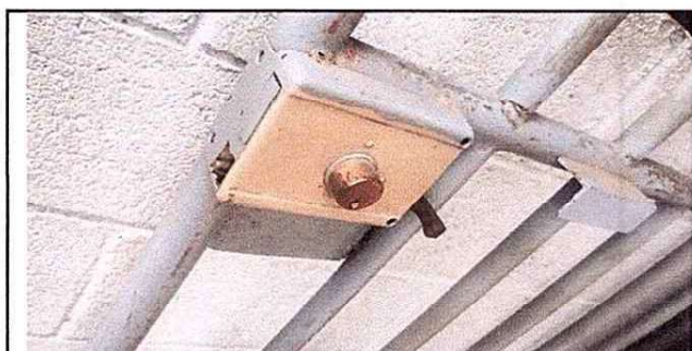
Foto 5: 4.2 Sustrución de chapa
