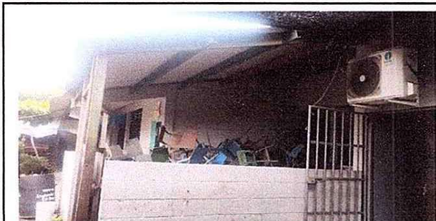
Foto1: 1.1 Sustrución de lamina por lamina troquelada aluzinc calibre 26
