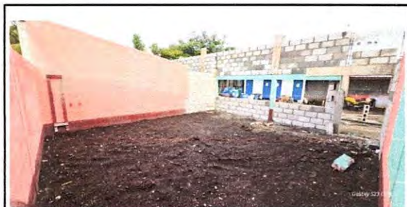
Foto 6: 6.6 Sustitución de piso de cemento líquido.
