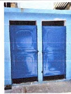
Foto 4: 4.4 Sustitución de puerta en servicios sanitarios.
