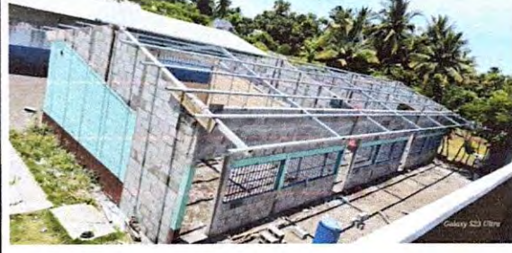
Foto 2: 2.2 Sustitución de estructura de soporte de madera, por metal.
