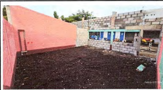
Foto 4: 6.6 Sustitución de piso de cemento líquido.
