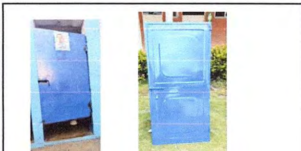
Foto 4: 4.4 Sustitución de puerta en servicios sanitarios.
