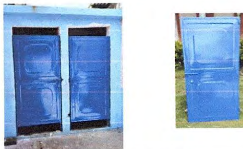
Foto 4: 4.4 Sustitución de puerta en servicios sanitarios.
