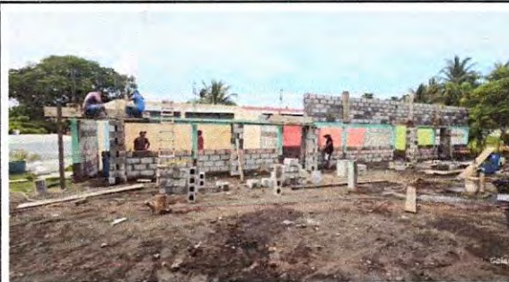
Foto 2: 1.3 Sustitución de elementos de fijación.
