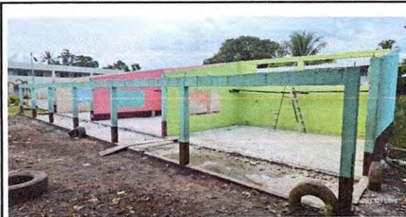
Foto 2: 19.9 Desinstalación de estructura portante
