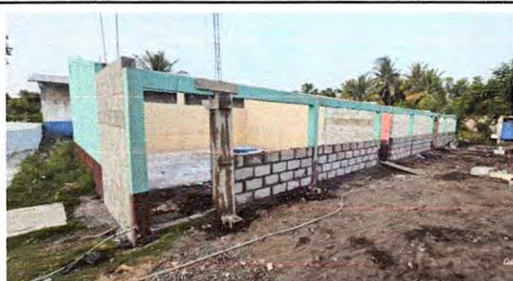
Foto 1: 1.3 Sustitución de elementos de fijación.
