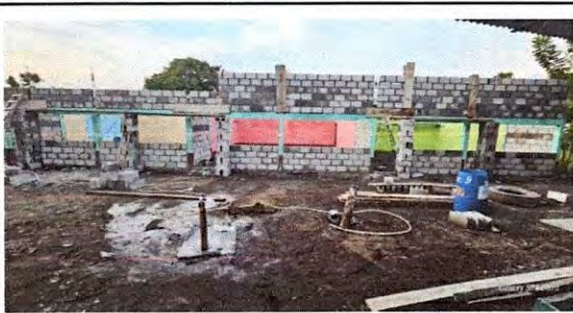
Foto 3: 1.3 Sustitución de elementos de fijación.
