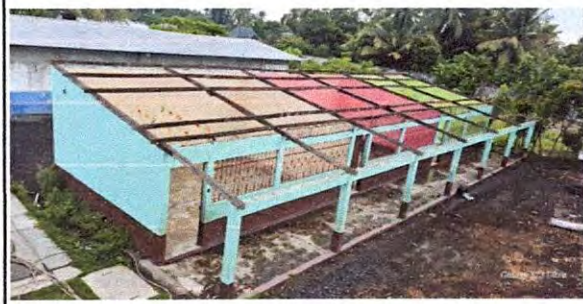
Foto 2: 19.9 Desinstalación de estructura portante
