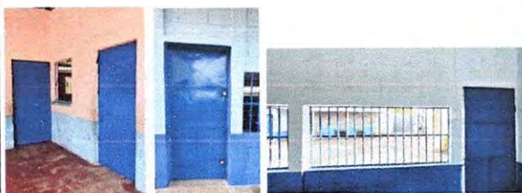
Foto 3: 4.1 Mantenimiento a estructura (lijado, cambio de tubo, cepillado, aplicación de pintura).
