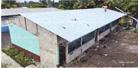
Foto 1: 1.1 Sustitución de lámina, por lámina troquelada aluzinc calibre 26. 1.2 Sustitución de capote de lámina para lámina troquelada. 1.3 Sustitución de elementos de fijación.
