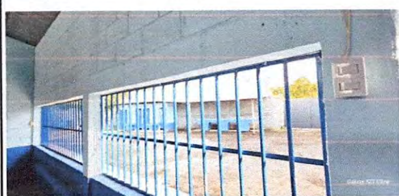
Foto 5: 5.6 Sustitución de balcones de metal.
