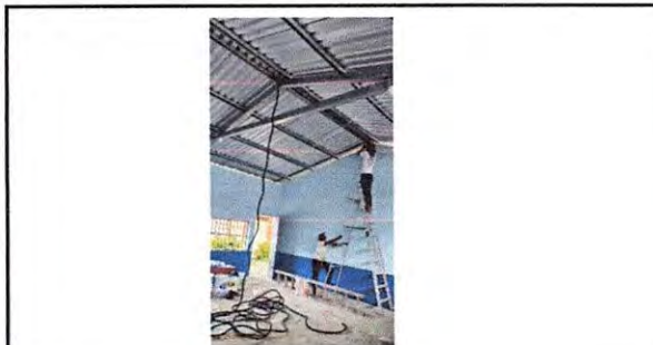
Foto 10: 17.11 Reparación de cableado eléctrico. 17.12 Sustitución de ducto eléctrico + accesorios
