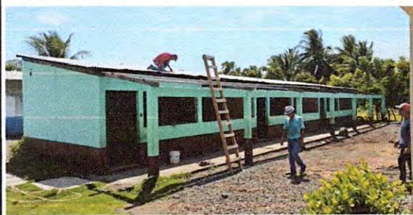
Foto1: 19.10 Desinstalación de lámina existente
