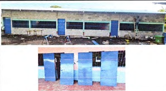
Foto 3: 4.1 Mantenimiento a estructura (lijado, cambio de tubo, cepillado, aplicación de pintura).
