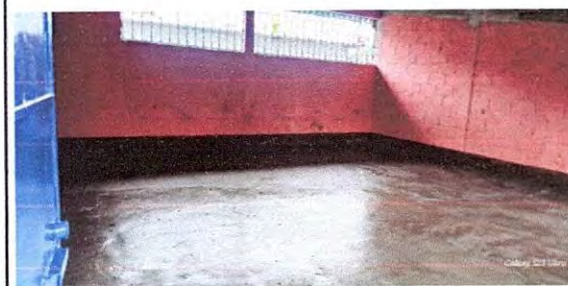
Foto 6: 6.6 Sustitución de piso de cemento líquido.
