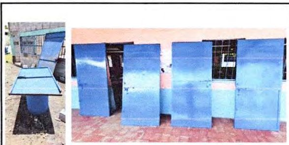
Foto 3: 4.1 Mantenimiento a estructura (lijado, cambio de tubo, cepillado, aplicación de pintura).
