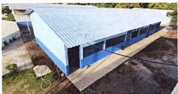
Foto 1: 1.1 Sustitución de lámina, por lámina troquelada aluzinc calibre 26. 1.2 Sustitución de capote de lámina para lámina troquelada. 1.3 Sustitución de elementos de fijación.
