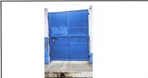
Foto 8: 12.1 Mantenimiento a portones de metal.
