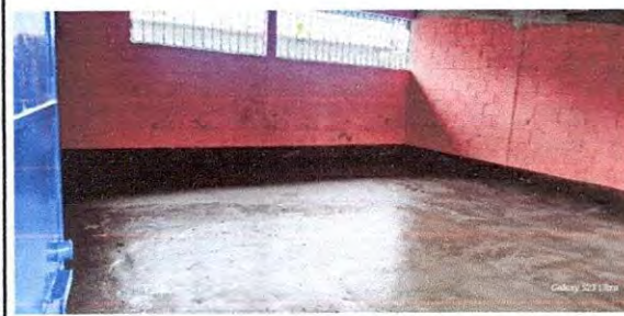
Foto 6: 6.6 Sustitución de piso de cemento líquido.
