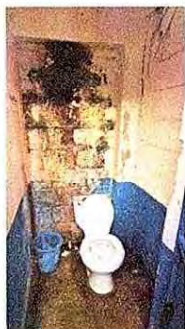
Foto 7: 10.2 Sustitución de accesorios de inodoro (contra llave, tubo de abasto). 10.3 Sustitución de inodoro.
