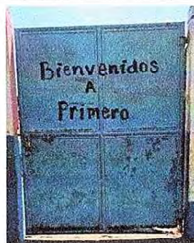
Foto 8: 12.1 Mantenimiento a portones de metal.
