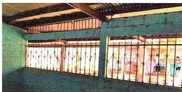
Foto 5: 5.6 Sustitución de balcones de metal.
