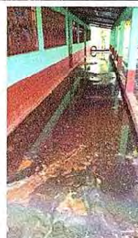
Foto 6: 6.6 Sustitución de piso de cemento líquido.
