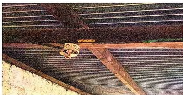
Foto 9: 17.4 Sustitución de focos ahorradores. 17.5 Sustitución de plafoneras. 17.7 Sustitución de interruptores dobles. 17.8 Sustitución de tomacorrientes dobles
