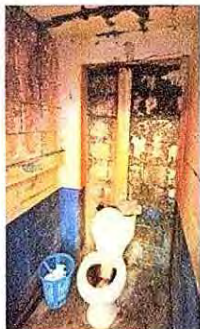
Foto 7: 10.2 Sustitución de accesorios de inodoro (contra llave, tubo de abasto). 10.3 Sustitución de inodoro.
