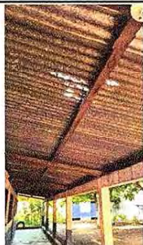
Foto 1: 1.1 Sustitución de lámina, por lámina troquelada aluzinc calibre 26. 1.2 Sustitución de capote de lámina para lámina troquelada. 1.3 Sustitución de elementos de fijación.
