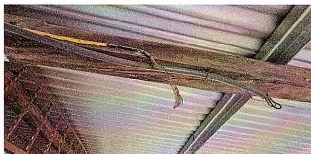
Foto 10: 17.11 Reparación de cableado eléctrico. 17.12 Sustitución de ducto eléctrico + accesorios
