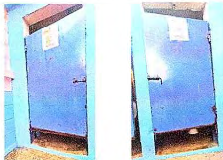
Foto 4: 4.4 Sustitución de puerta en servicios sanitarios.
