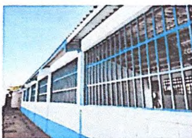
Foto 7: 5.2 Sustitución de estructura de metal de ventana.
