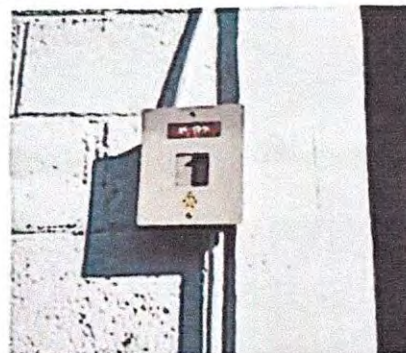
Foto 16 17.10 Sustitución de tablero de flipones.
