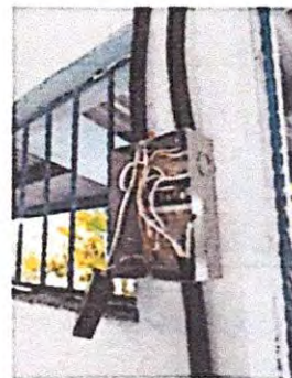
Foto 16 17.10 Sustitución de tablero de flipones.
