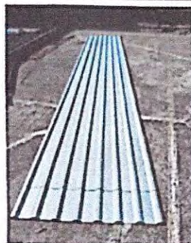
Foto1: 1.1 sustitucion de lamina, por lamina troquelada aluzinc calibre 26,
