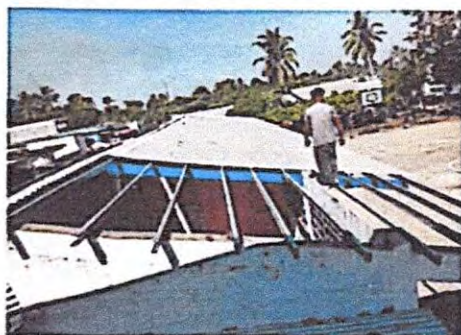
Foto 3: 1.3 Sustitución de elementos de fijación.
