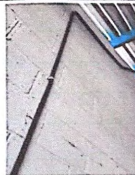
Foto 18 17.12 Sustitución de ducto eléctrico.
