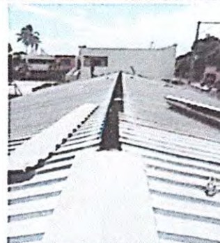
Foto 2: 1.2 sustitucion de capote de lamina para lamina troquelada.
