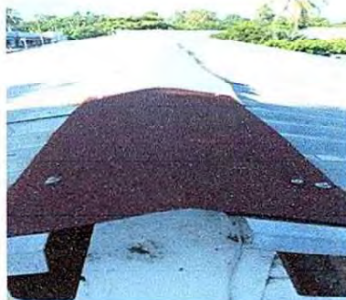
Foto 2: 1.2 Sustitución de capote de lamina para lamina troquelada.
