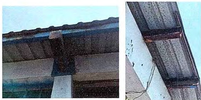
Foto 5: 2.3 Sustitución de estructura de soporte de metal, por metal.
