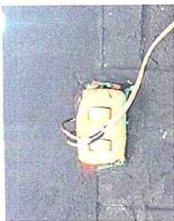
Foto 13 17.7 Sustitución interruptores dobles
