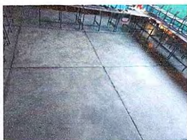
Foto 9: 6.8 Sustrucción de piso cerámico
