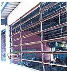
Foto 7: 5.2 Sustrucción de estructura de metal de ventana
