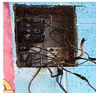
Foto 16 17.10 Sustitución de tablero de flipones
