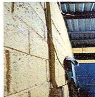
Foto 18 17.12 Sustitución de ducto eléctrico
