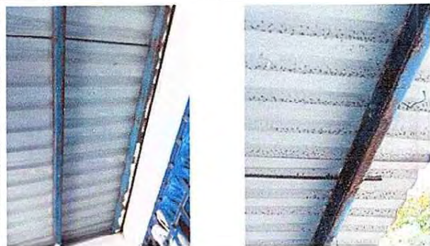
Foto1: 1.1 Sustitución delamina, por lamina troquelada aluzinc calibre 26
