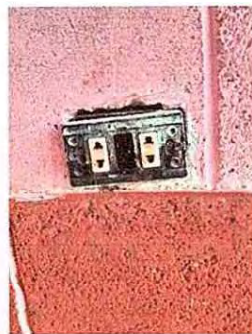
Foto 14 17.8 Sustitución de tomacorrientes dobles
