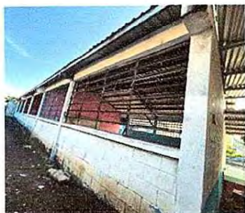
Foto 7: 5.2 Sustrucción de estructura de metal de ventana
