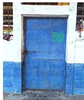
Foto 6: 4.3 Sustitución de puerta.
