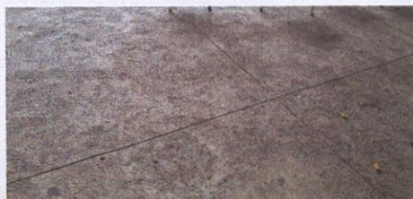
FOTO 5: PISO (sustitución de piso cerámico)
