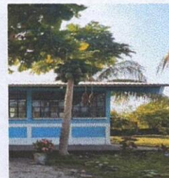
FOTO 6: PINTURA EN MUROS EXTERIORES E INTERIORES
