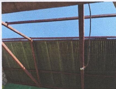
FOTO 2: ESTRUCTURA DE TECHO (mantenimiento de estructura y sustitución de soporte de madera por metal)
