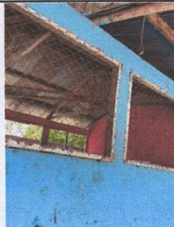
FOTO 4: VENTANAS (sustitución de estructura de metal)
