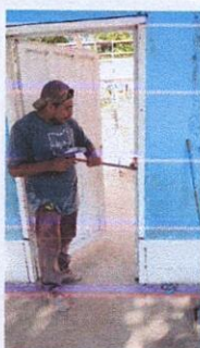
Foto 3: PUERTAS DE METAL: Sustitución de puerta y en servicios sanitarios
