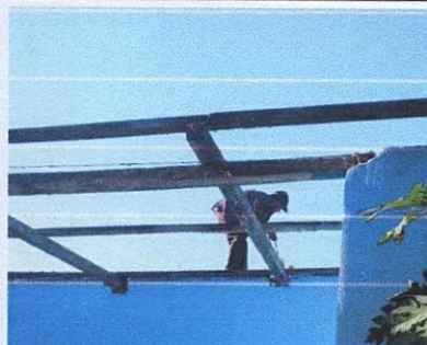
Foto 2: ESTRUCTURA DE TECHO: Sustitución de estructura de soporte
