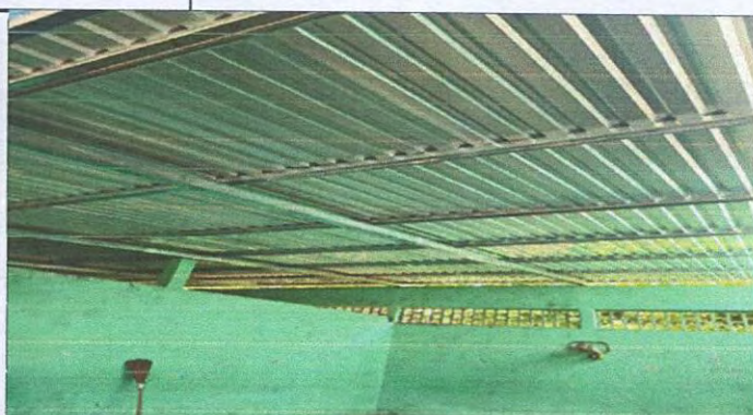
Foto 2: MANTENIMIENTO A ESTRUCTURA DE SOPORTE DE METAL
