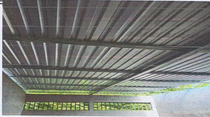
Foto 1: SUSTITUCION POR LAMINA, POR LAMINA TROQUELADA ALUZING 26
