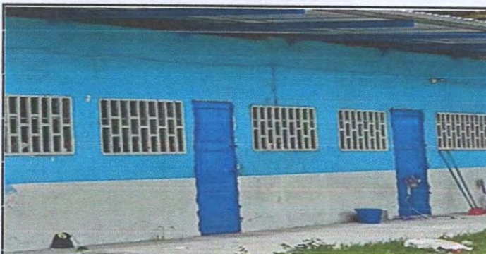
Foto 3: SUSTITUCION DE PUERTA
