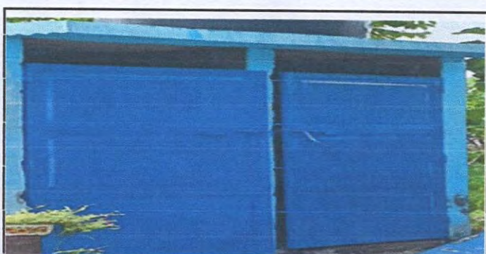
Foto 4: SUSTITUCION DE PUERTA DE SERVICIO SANITARIO
