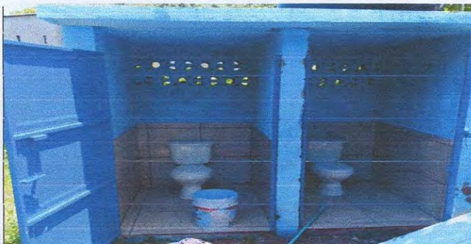
Foto 9: SUSTITUCION DE INODOROS
