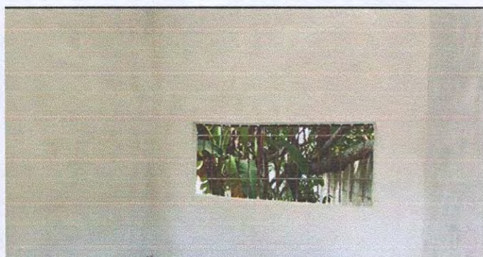
Foto 12: REPELLO EN MURO
