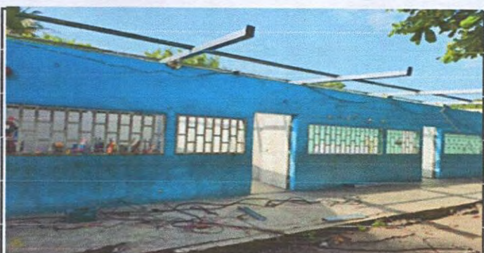
Foto 5: SUSTITUCION DE BALCONES DE METAL
