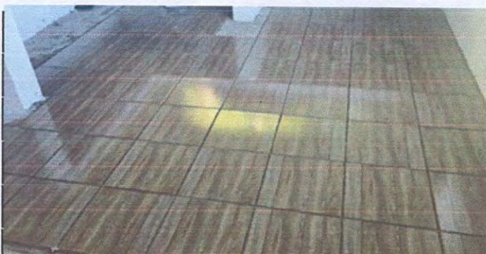
Foto 6: SUSTITUCION DE PISO CERRAMICO
