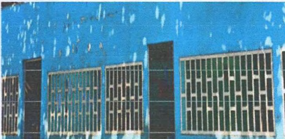
Foto 5: SUSTITUCION DE BALCONES DE METAL
