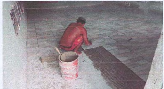
Foto 6: SUSTITUCION DE PISO CERRAMICO
