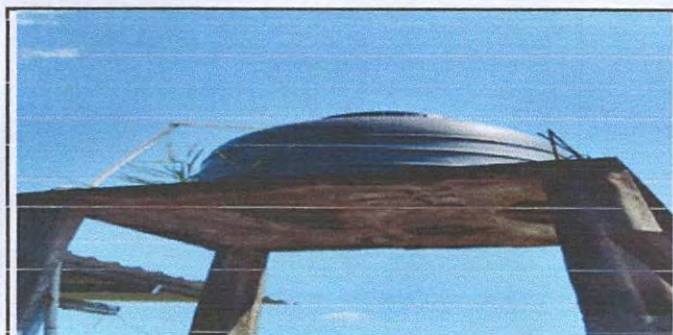
Foto 11: SUSTITUCION DE DEPOSITO DE AGUA 1100 LT
