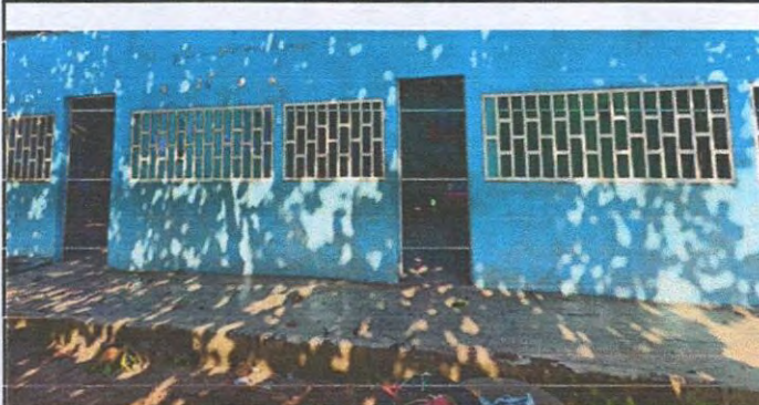
Foto 3: SUSTITUCION DE PUERTA
