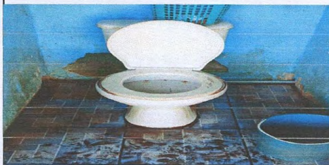
Foto 9: SUSTITUCION DE INODOROS
