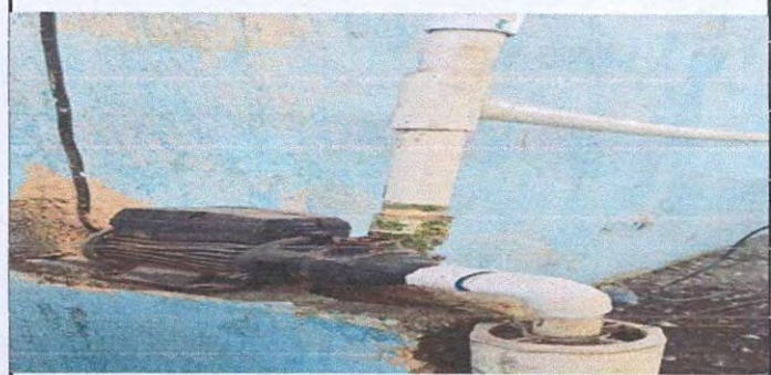
Foto 10: SUSTITUCION DE BOMBA DE AGUA
