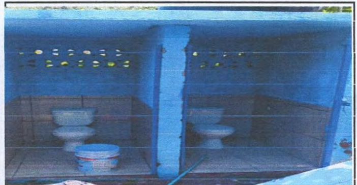
Foto 4: SUSTITUCION DE PUERTA DE SERVICIO SANITARIO
