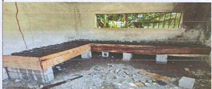
Foto 8: SUSTIRUCION DE ESTUFA RURAL COMPLETA
