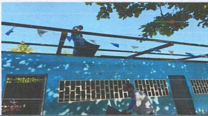
Foto1: SUSTITUCION POR LAMINA, POR LAMINA TROQUELADA ALUZING 26
