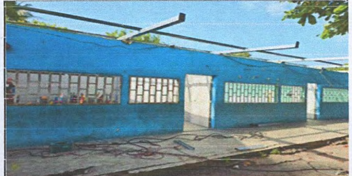
Foto 2: MANTENIMIENTO A ESTRUCTURA DE SOPORTE DE METAL
