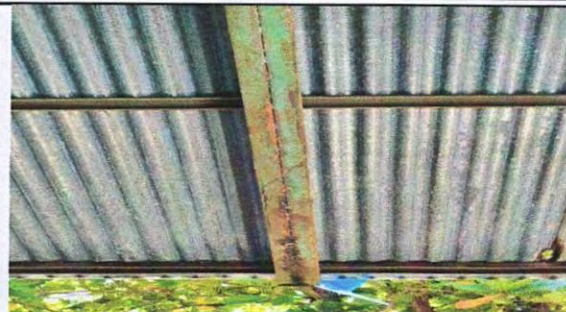
Foto 2: 2.1 Mantenimiento a estructura de soporte de metal
