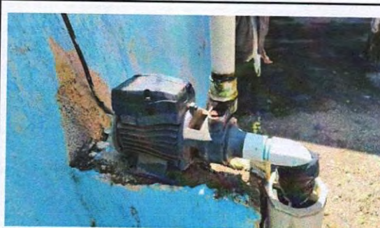
Foto 10: 18.7 Sustitución de bomba de agua
