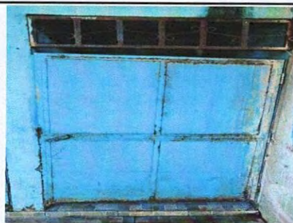
Foto 4: 4.4 Sustrucción de puerta en servicios sanitarios
