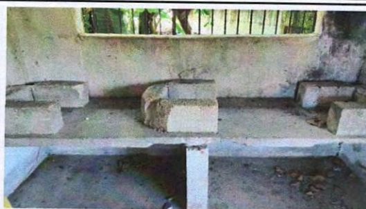
Foto 8: 20.2 Sustitución de estufa rural completa
