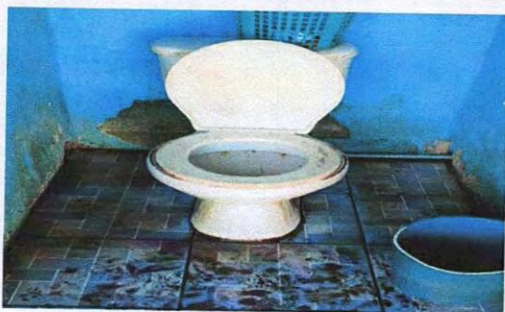
Foto 9: 10.3 Sustitución de inodoro
