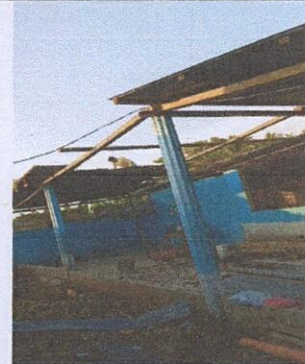
Foto 2: SUSTITUCIÓN DE ESTRUCTURA DE MADERA, POR METAL
