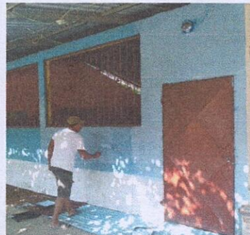
Foto 4: SUSTITUCIÓN DE PUERTAS DE AULAS
