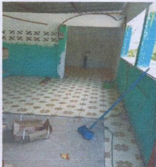
Foto 5: SUSTITUCIÓN DE PISO CERAMICO
