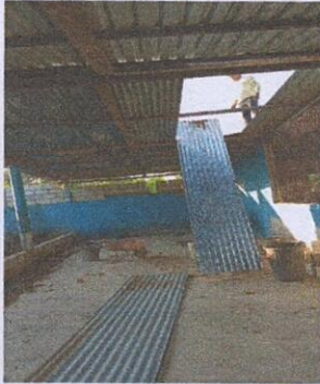
Foto 1: SUSTITUCIÓN DE LAMINA, POR LAMIAN TROQUELADA ALUZINC
