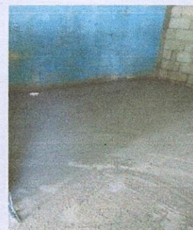
Foto 6: REPARACIÓN DE PISO DE TORTA DE CONCRETO
